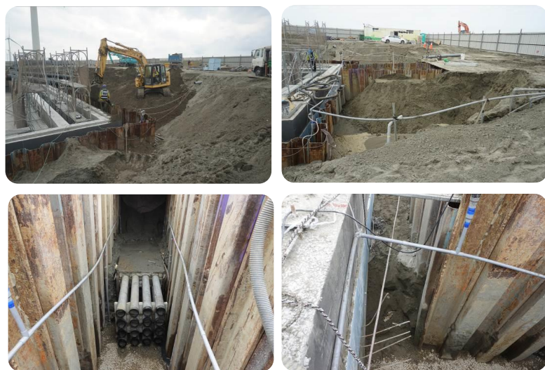
114.04地下管排開挖監看情形
